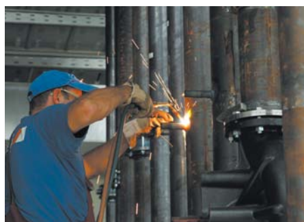
Gauß-Monteur beim Aufbau eines Heizungsverteilers
